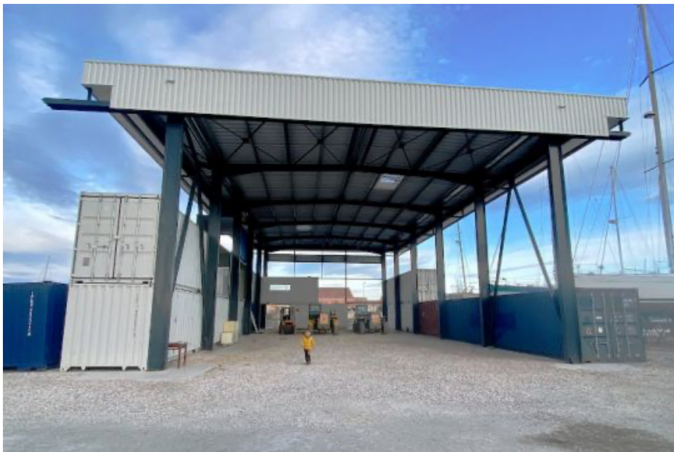
Travaux du chantier naval Carina Ulixis à Port Leucate
